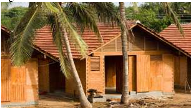
Figura 2 – Fachada Kirinda House – materiais.
