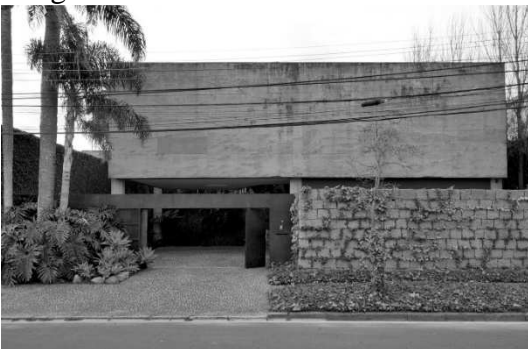
Imagem 09 – Residência Niclewicz: fachada
