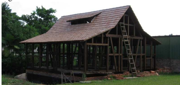
Figura 17 - Telhado de uma casa com técnica construtiva enxaimel.
