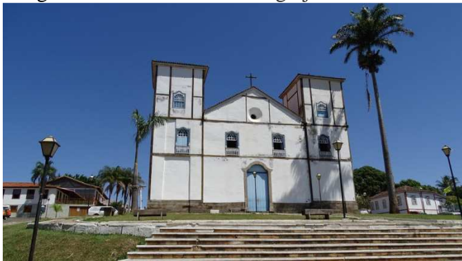
Imagem 11 - Vista frontal da igreja Matriz Nossa Senhora do Rosário- Pirenópolis- GO
