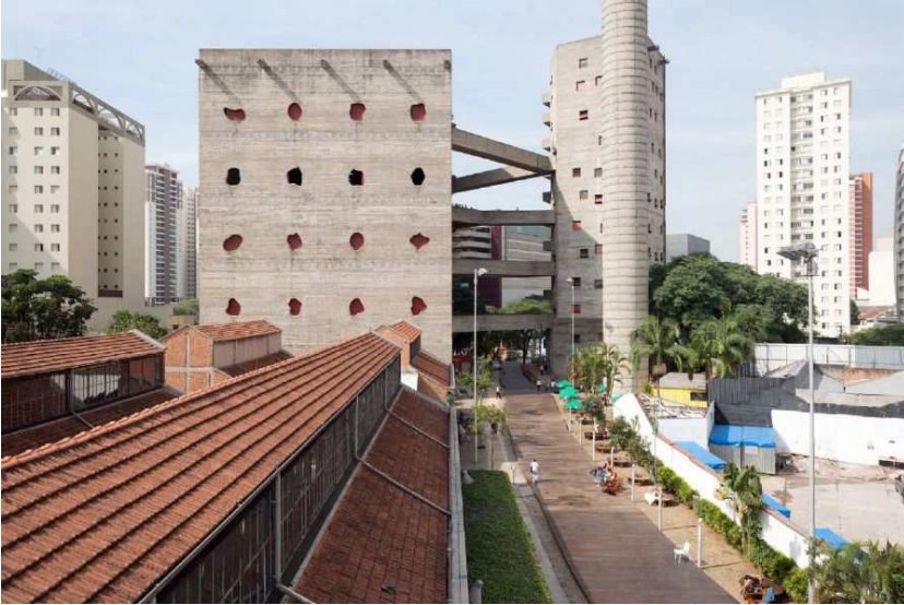
Figura 5 – Brutalismo, vista da caixa d'água e os novos volumes.
