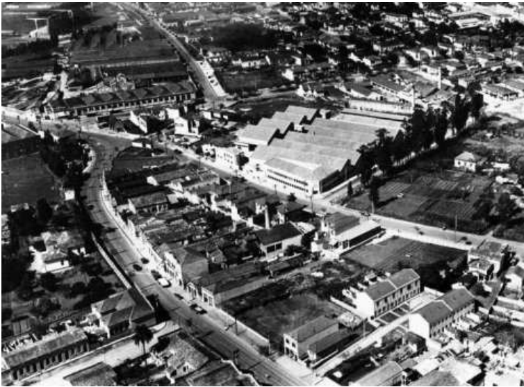
Figura 2 - Vista aérea geral da Fábrica da Pompéia antes da Reforma.
