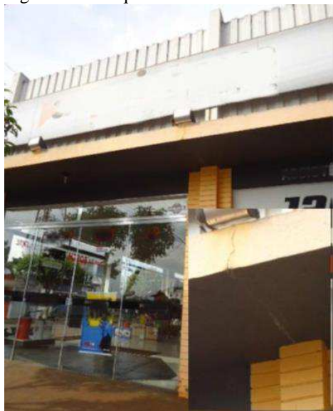
Figura 9 – Marquise T - Manchas de umidade e trincas.
