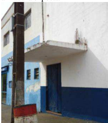
Figura 6 – Marquise N - Manchas de umidade, bolor, fissuras, descolamento revestimento argamassado, de pintura e armadura exposta.
