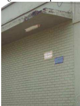
Figura 7 – Marquise W - Umidade, bolor, trincas, descolamentos da argamassa, fissuras, trincas e armadura exposta.
