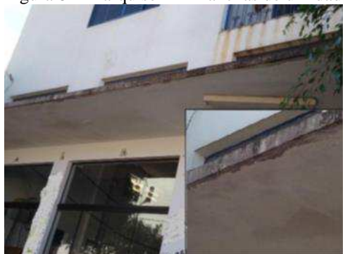
Figura 8 – Marquise A - Manchas de umidade e bolor.
