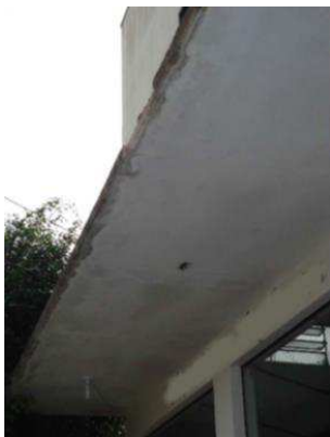
Figura 5 – Marquise H - Manchas de umidade, bolor, fissuras e descolamento argamassa e pintura e armadura exposta.
