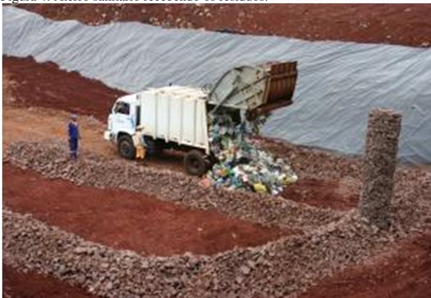
Figura 4: Aterro sanitário recebendo os resíduos.
