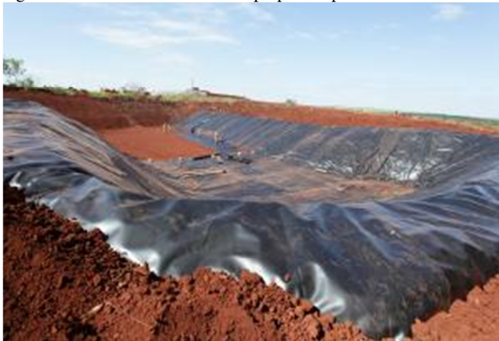
Figura 3: Área do aterro sanitário preparada para receber os resíduos.
