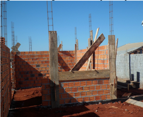
Figura 3- Montagem de formas para os pilares, e levantamento de paredes.
