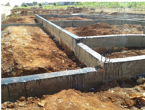
Figura 2- Viga baldrame em execução.
