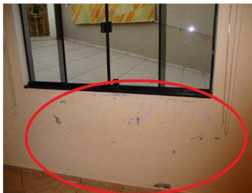
Figura 8 - Infiltração na parede do dormitório do pavimento inferior
