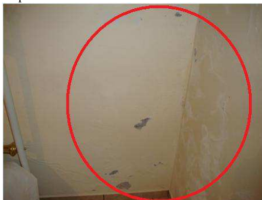
Figura 9 – Infiltração na parede do dormitório do pavimento inferior
