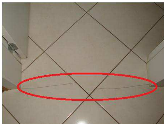
Figura 7 - Fissura no piso do pavimento superior
