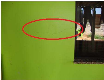
Figura 15 – Fissura na parede.
