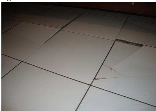
Figura 11 - Descolamento do revestimento cerâmico.
