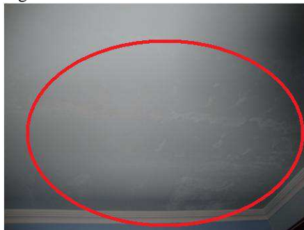
Figura 3 - Manchas de umidade no forro.
