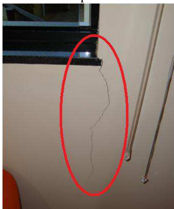
Figura 5 – Fissura na parede.
