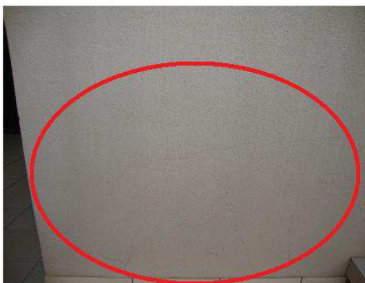
Figura 10- Fissuras no revestimento argamassado
