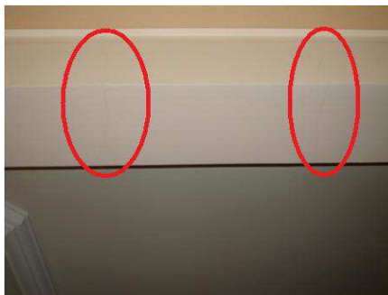
Figura 4 - Fissuras na viga
