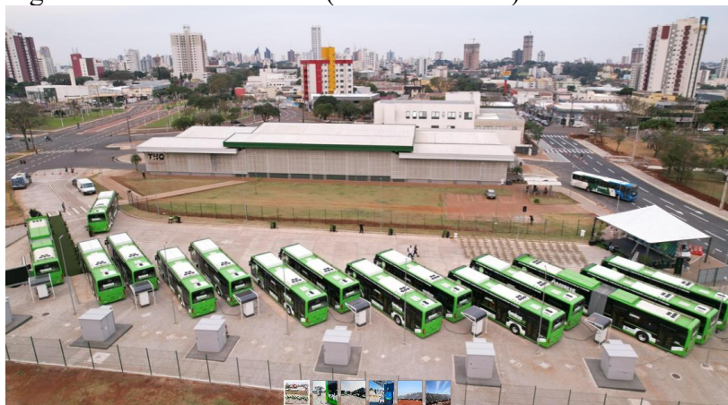
Figura 12 – Eletro terminal (Terminal Oeste) de Cascavel/PR
