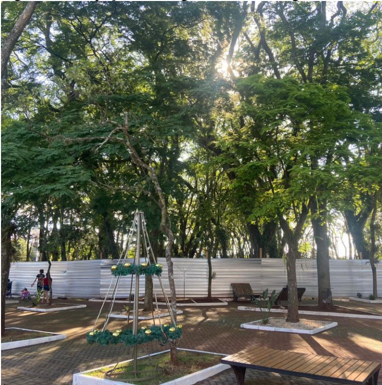
Figura 03 – Espaço livre original de Pato Bragado, sob reforma.
