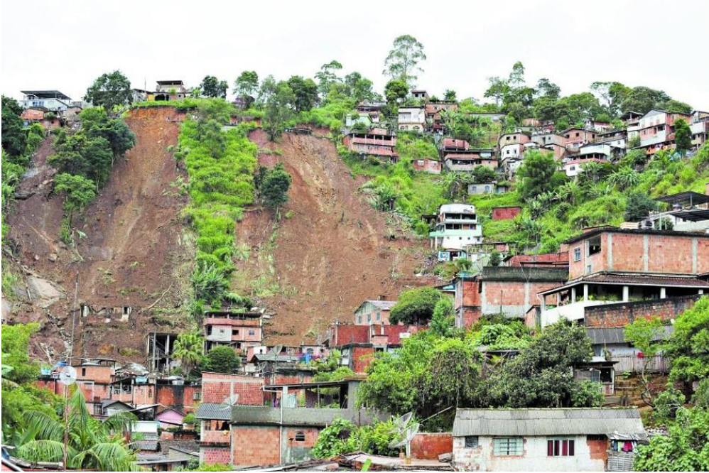
Figura 01 – Ocupação Irregular, Nova Friburgo - RJ.
