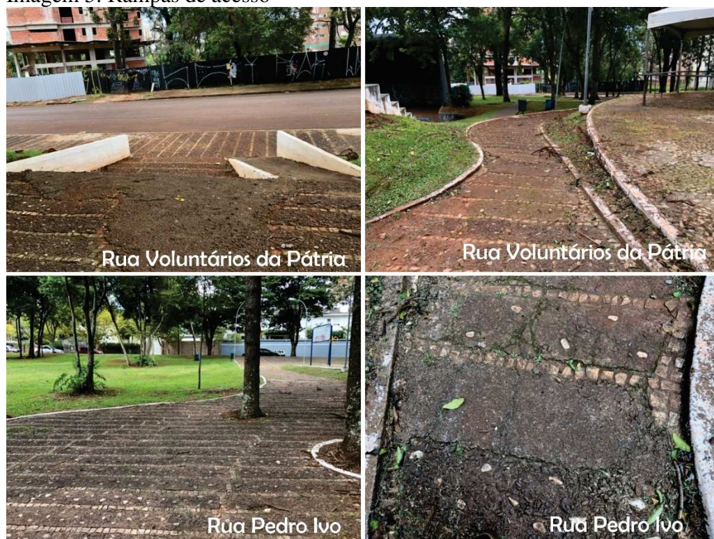
Imagem 5: Rampas de acesso
