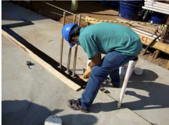
Figura 6 – Impermeabilização contrapiso.
