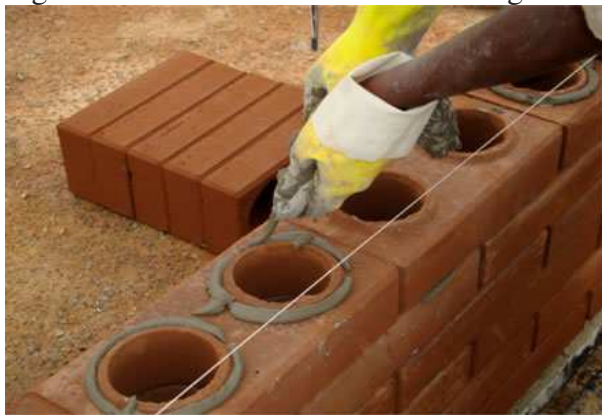
Figura 7 – Cola PVA misturada com argamassa.
