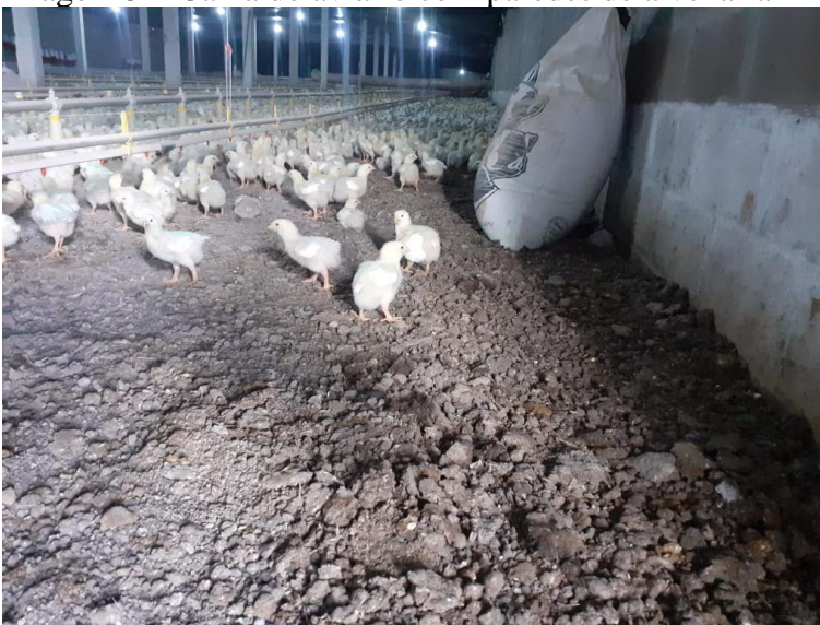
Imagem 5 – Cama do aviário com paredes de alvenaria
